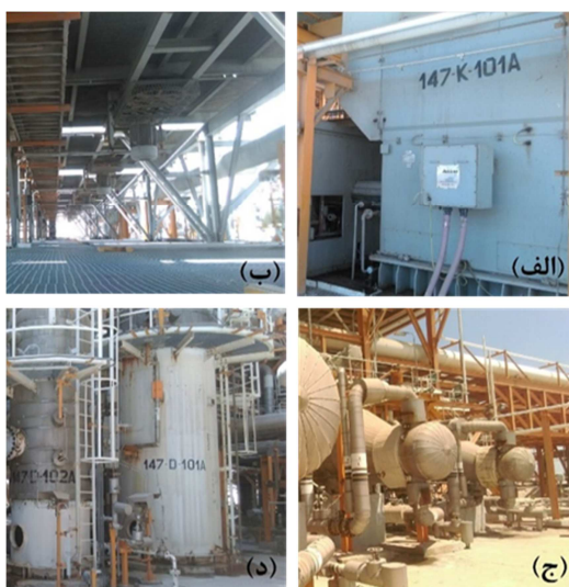
شکل ۱- تجهیزات چرخه خنک سازی پروپان (الف) کمپرسور (ب) چگالنده (ج) مبادله کن های گرما در نقش تبخیر کن (د) درام های مکش
