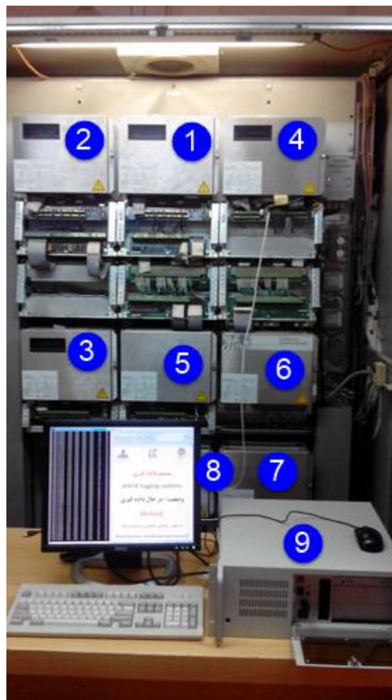
شکل ۳: سامانه کنترل و مانیتورینگ توربین گاز، SPEEDTRONIC.
