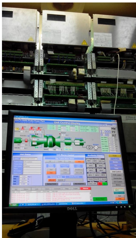
شکل ۹: مانیتورینگ توربین گاز با استفاده از Cimplicity که به صورت برخط به پایگاه داده SQL متصل است.
