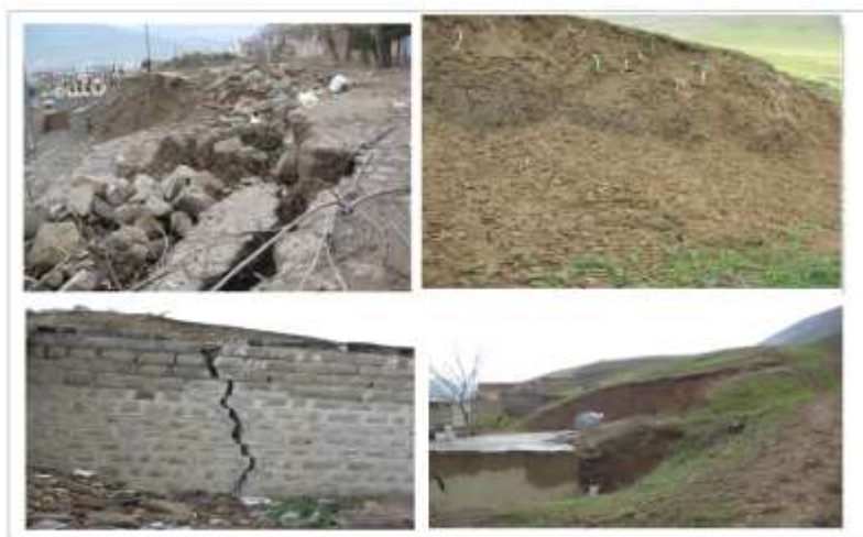
شکل ۶: تصاویر زمین‌لغزش شهرستان گرمی Fig (6): Landslide photo of Germei city
