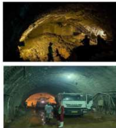
شکل ۲- ریزش بخشی از تاج و دیواره های تونل قطارشهری کرمانشاه در حین انجام حفاری آن.
