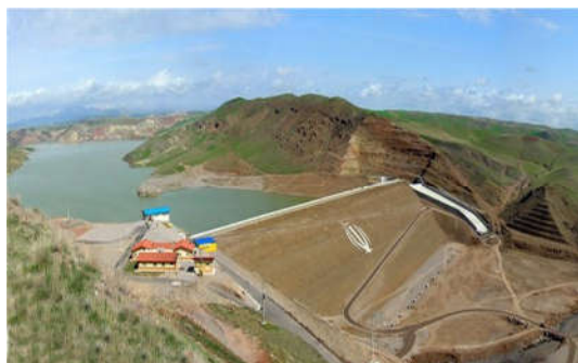
شکل ۱- نمایی از بدنه سد و دریاچه و ساختمان های بهره برداری [۲۷]
