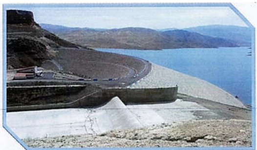
شکل ۲- نمایی از سد مخزنی آغ چای
