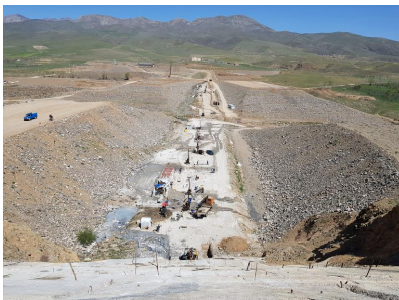
شکل ۲- تصویری از عملیات تزریق پرده آب‌بند ساختگاه سد پیغام‌چای کلیبر (دید به سمت تکیه‌گاه چپ).
