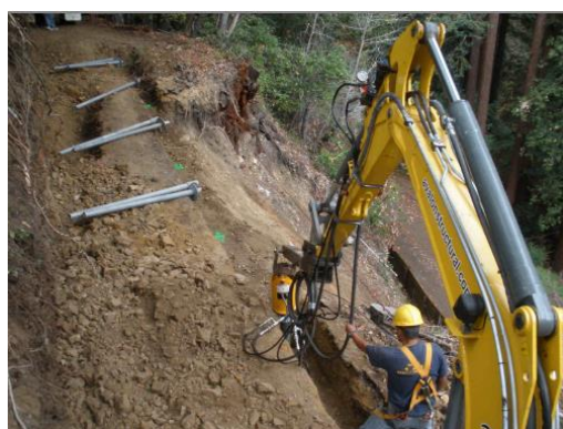
شکل ۲- نمونه‌ای از تثبیت شیب با شمع مارپیچ (Avalon Structural, Inc., ۲۰۱۵)
