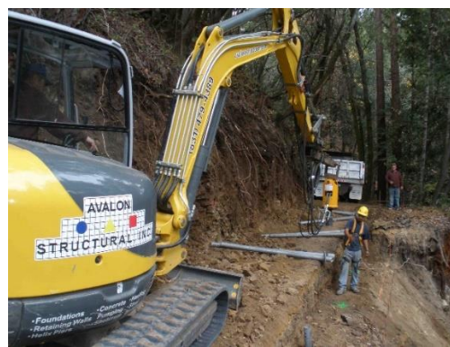
شکل ۲- نمونه‌ای از تثبیت شیب با شمع مارپیچ (Avalon Structural, Inc., ۲۰۱۵)
