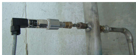
شکل ۳- حس گر فشار ۴۰۰ بار در ابتدای خط
