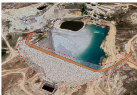
شکل ۱۶- عکس هوایی گزینه بهینه برای ترفیع سد تا تراز ۲۰۹۵. Figure 16- Aerial image of the dam body area after raising to level 2095 using the optimal method.
