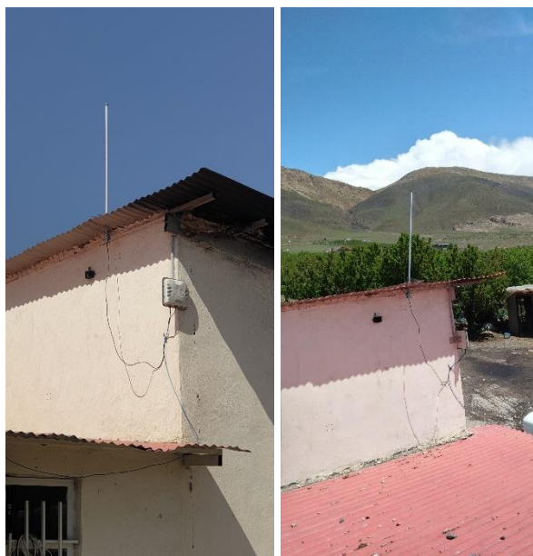
شکل ۲. نصب نود حسگر بی سیم دما و رطوبت نسبی هوا، گیت‌وی و آنتن در باغ
